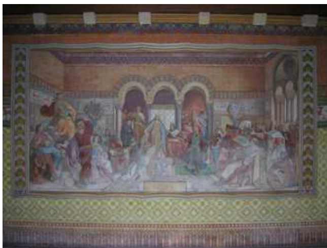
Bild 7: Sängerkriegsbild – Starke Schäden befinden sich im unteren Teil des Bildes. Mit der Höhe nimmt das Ausmaß der Schäden ab. (Bild von Restaurator Jürgen Scholz)
