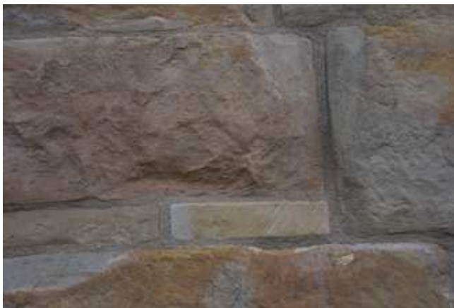
Bild 4: Detail einer Wandfläche an der Westseite des Palas – Für die Überarbeitung wurden von der MFPA entwickelte acrylatgebundener Steinerfüllmörtel für Rättsandsteine und ein spezieller mineralisch gebundener Verfugmörtel verwendet.
