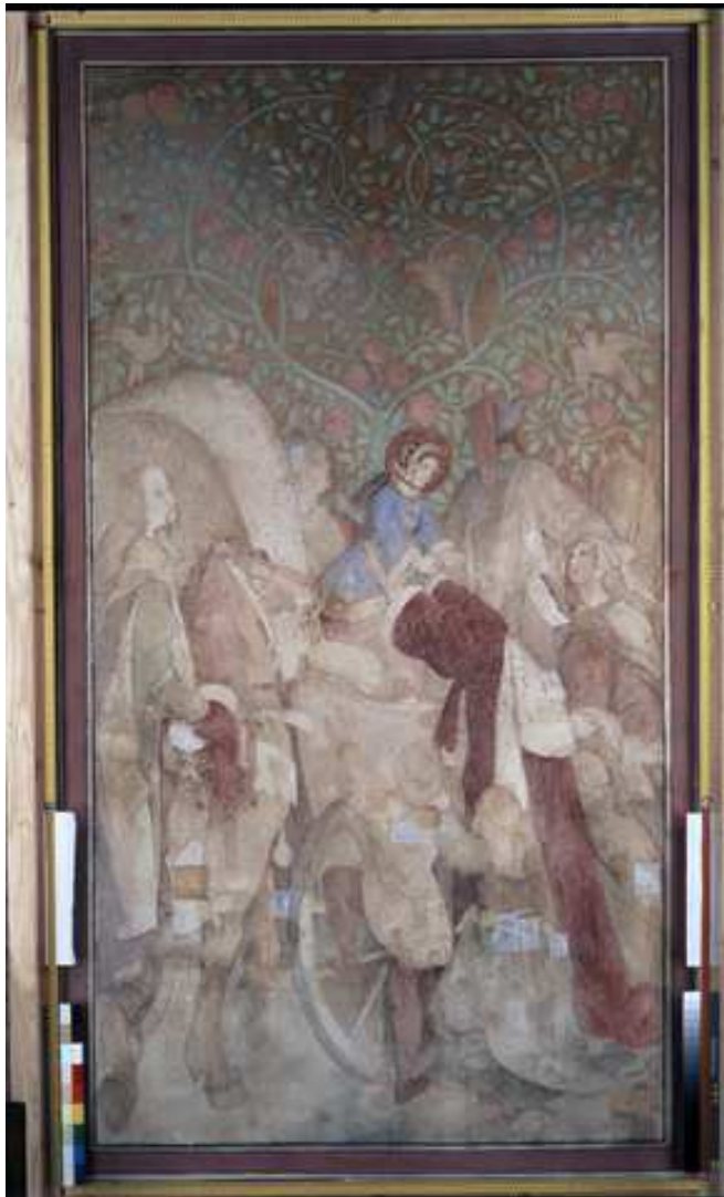
Bild 6: Fresko „Ankunft der heiligen Elisabeth auf der Wartburg“ – Deutlich erkennbar sind von oben nach unten zunehmende Schäden an der Bildoberfläche. Diese sind durch Salzbelastungen im Putz und im Mauerwerk bedingt. (Bild von Restaurator Jürgen Scholz)
