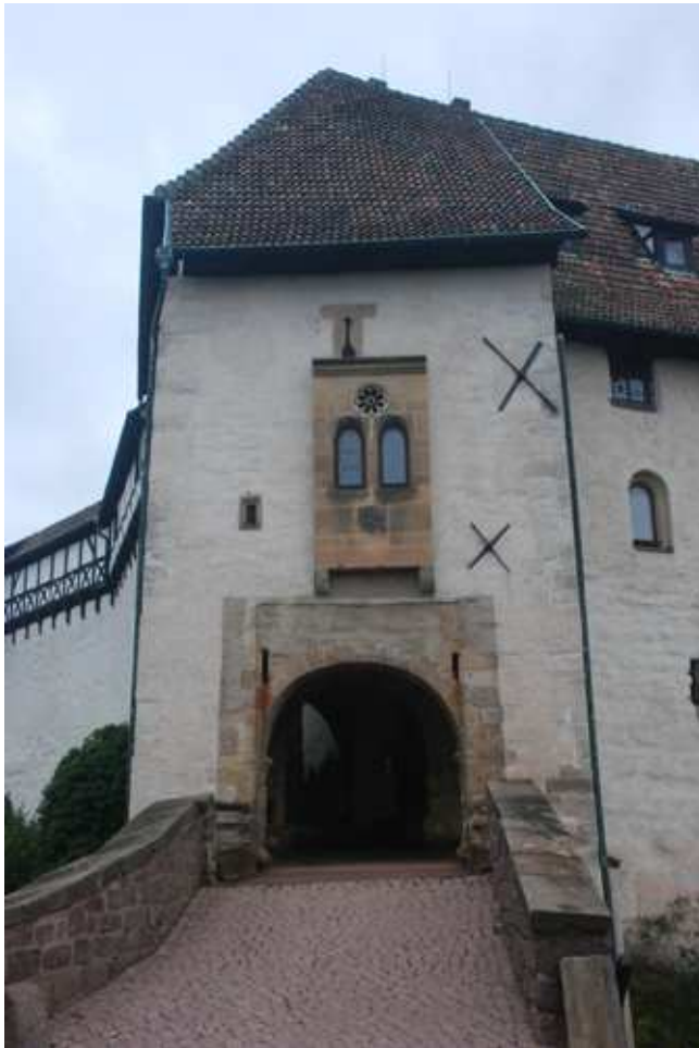
Bild 1: Zugang zur Wartburg durch eine dreitorige Halle – Der Putz wurde 1995 ausgebessert und farblich überarbeitet. Es kamen durch die MFPA entwickelte Mörtel zum Einsatz. Aktuelle erfolgen Putzausbesserungen und Ergänzungen mit einem speziell entwickelten Putzsystem
