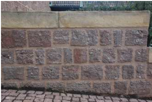
Bild 2: Sanierte Mauer vor der Dirnitz – Zur Neuverfugung kamen von der MFPA entwickelte Mörtelsysteme zum Einsatz. Verschiedene Variationen dieses Mörtels in Farbigkeit und Struktur kommen bei der Restaurierung der Wehrmauern zur Anwendung.
