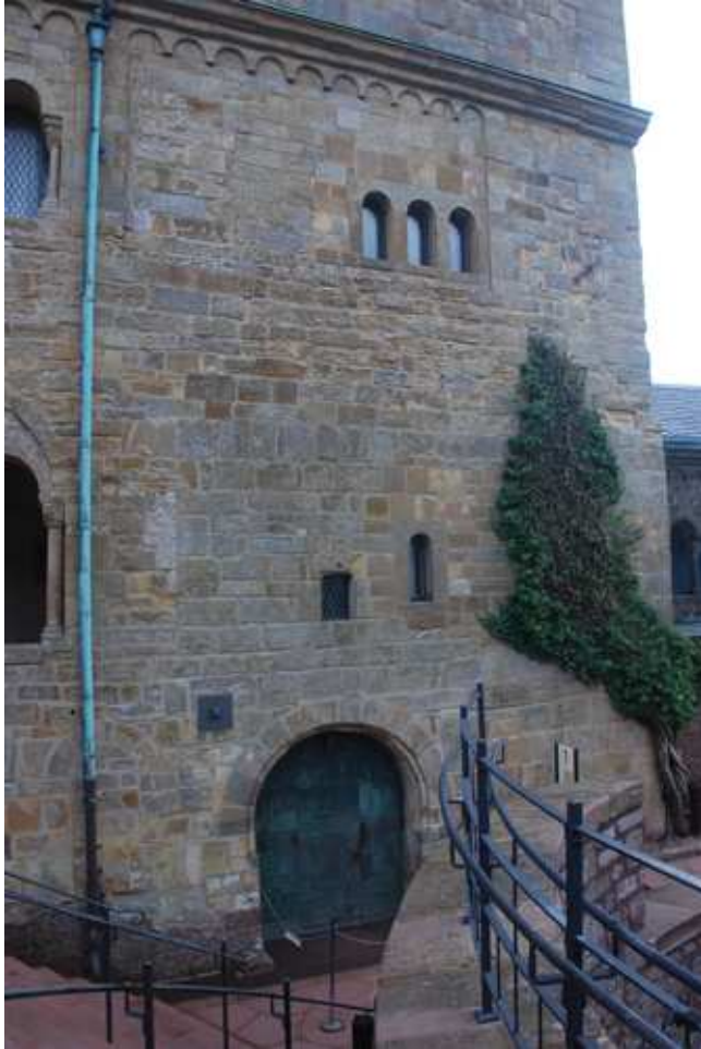
Bild 3: Südlicher Teil der Westfassade des Palas – Bei der denkmalgerechten Restaurierung wurden von der MFPA entwickelte acrylatgebundene Steinrestauriermörtel und mineralische Verfugmörtel eingesetzt.
