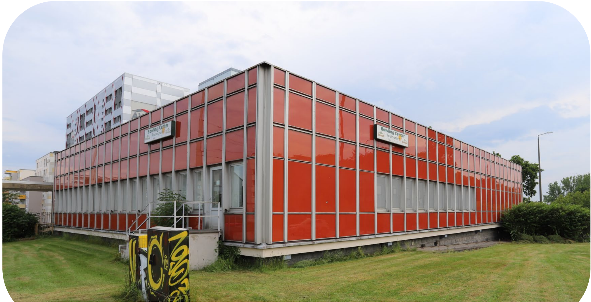
“Roter Würfel” in Plauen (Vogtland), 1985 (farbig hinterlegtes Sicherheitsglas)
