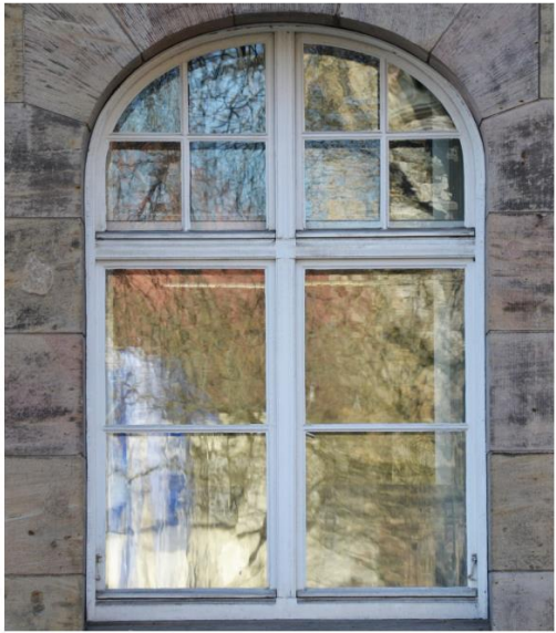
Abb. 2. Originale Verglasung der sog. Wilhelmstpost in Bamberg, © Ruth Tenschert, KDWT
